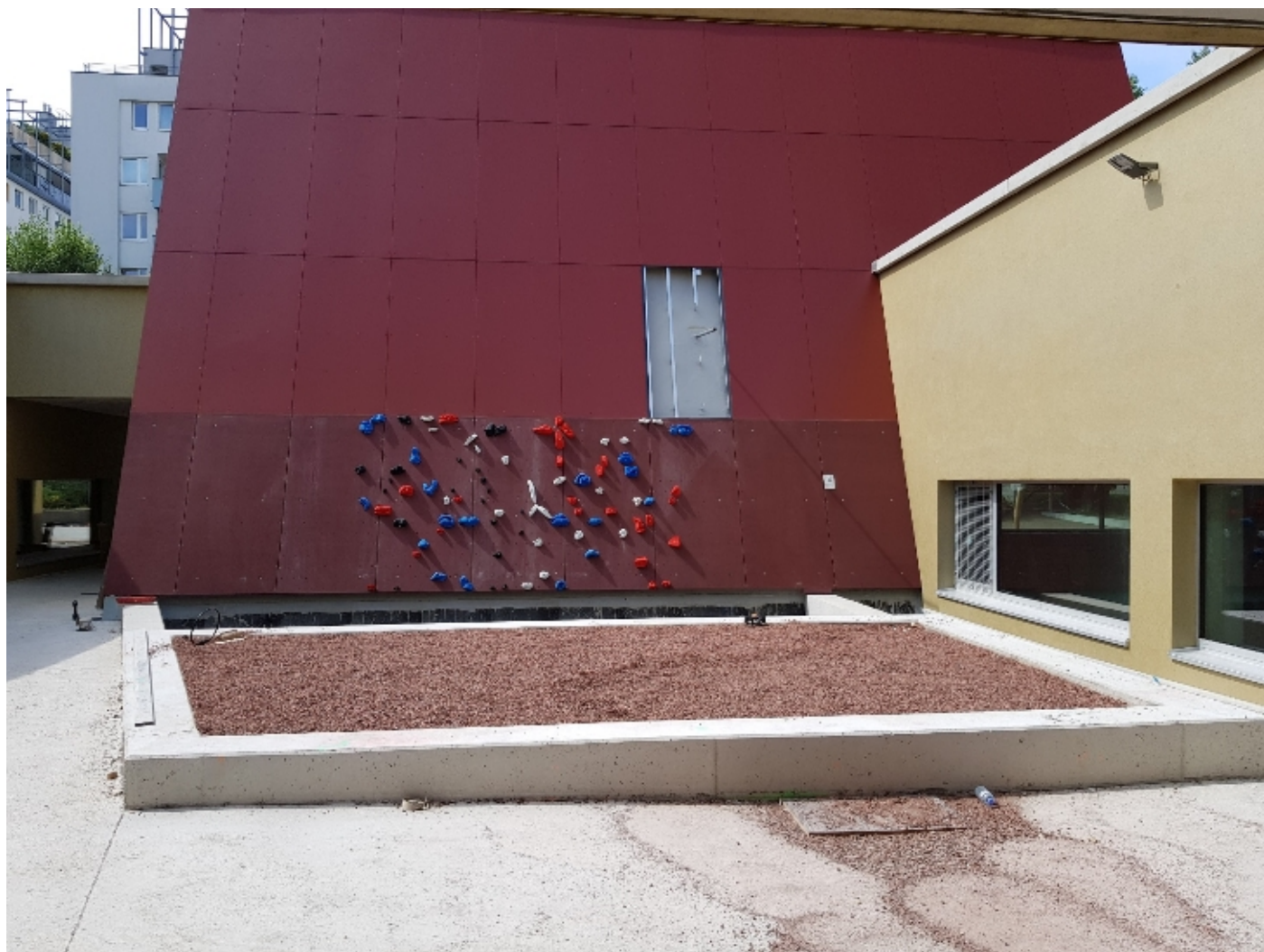
Abbildung 11, GFK Outdoor Boulderwand in Fassade integriert für Granit Bau, GTVS Spielmannngasse Wien, ca. 27m 2
