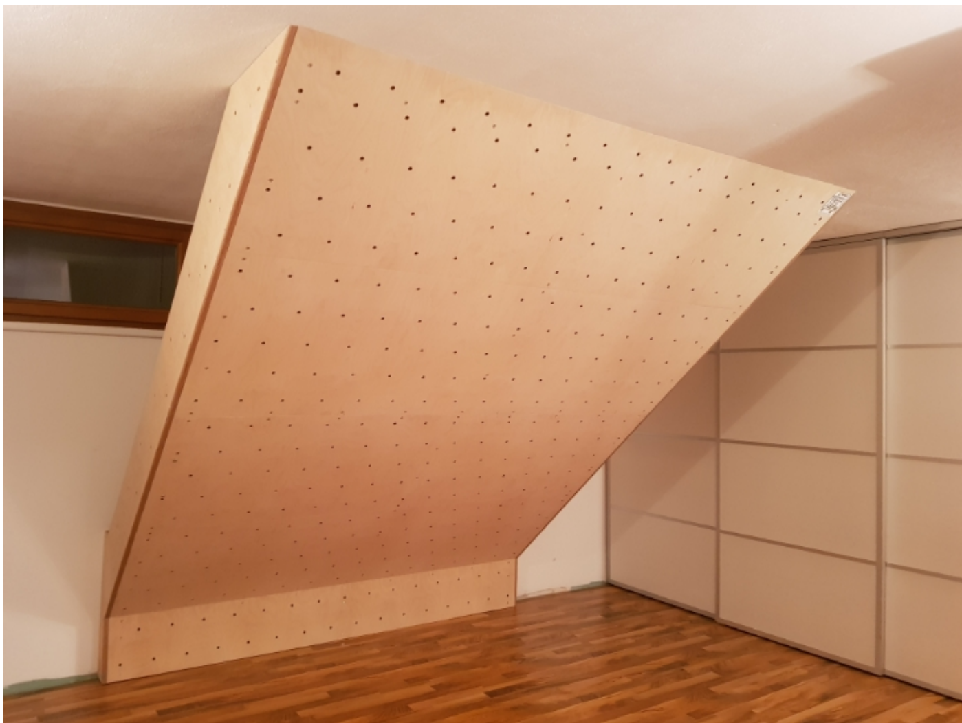
Abbildung 48: fixe Spraywall mit Glas/Epoxi Beschichtung, privat Wien
