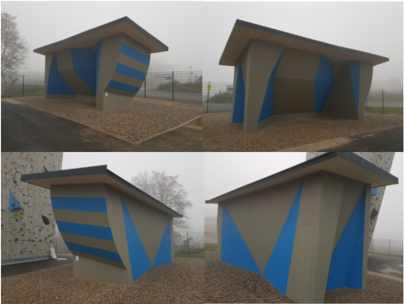
Abbildung 26: Outdoor Boulderturm Bodensdorf Gemeinde Wieselburg Land, NÖ, 104m 2 , 4,2m hoch, Pultdach, Fallschutz mit Kiesbett, Herbst 2020
