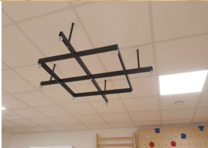
Abbildung 34: Ergotherapie Wurm-König Kilb, NÖ, 2023 Deckenkreuz für Schaukel durch Zwischendecke abgehängt
