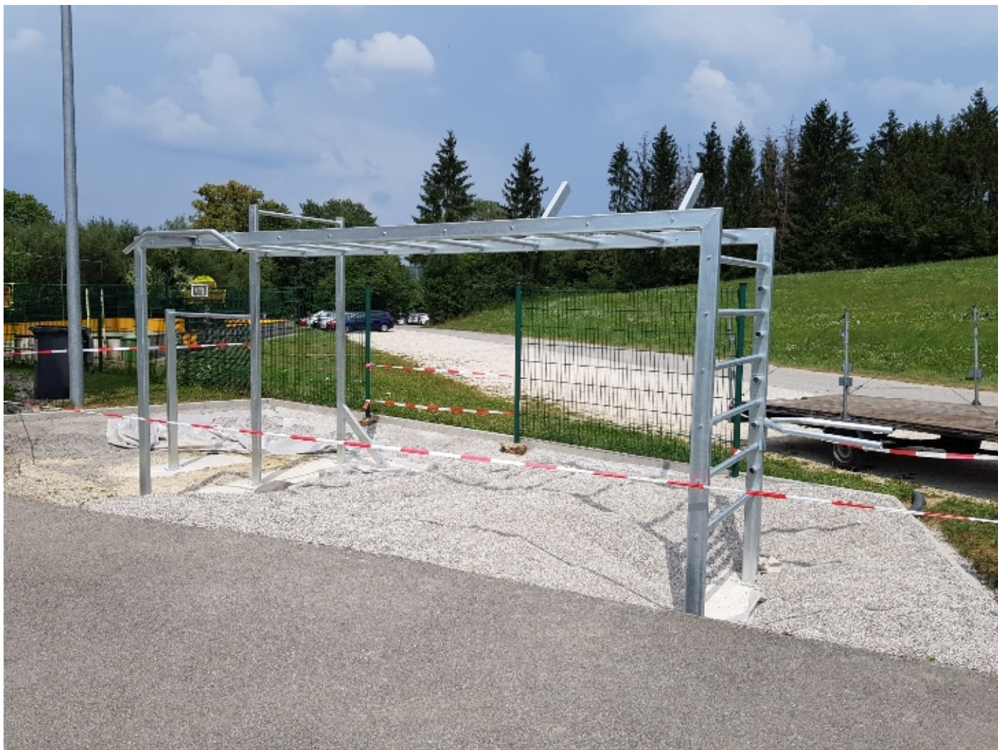
Abbildung 25, Trainingsgerüst für AV Haag, NÖ, Sommer 2018
