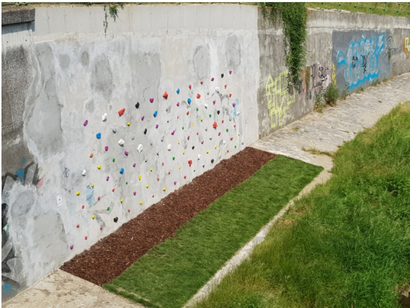
Abbildung 46: Outdoor Kletteranlage am Wienfluss, Befestigung der Griffe auf Beton/Stein/Mischmauerwerk
