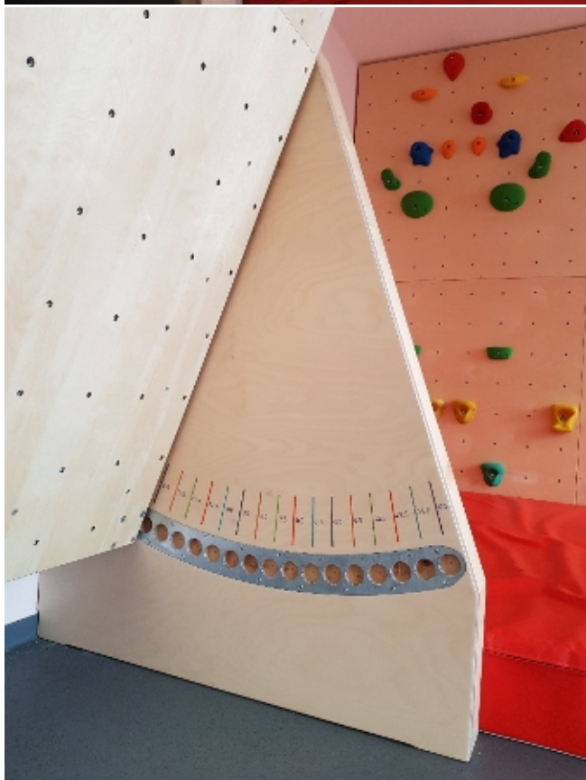
Abbildung 12, Verstellbereich \pm 20^\circ mit 2,5^\circ Schritten
