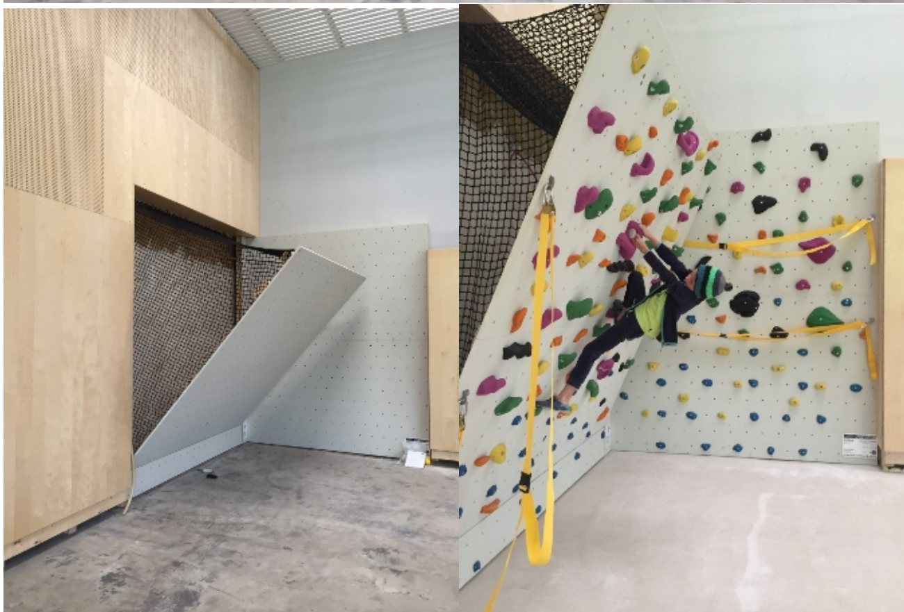
Abbildung 31, Kippwand mit anschließend fixem Wandbereich, Betretungsschutznetz - gebaut für ArtRock - HTL Jenbach, Tirol
