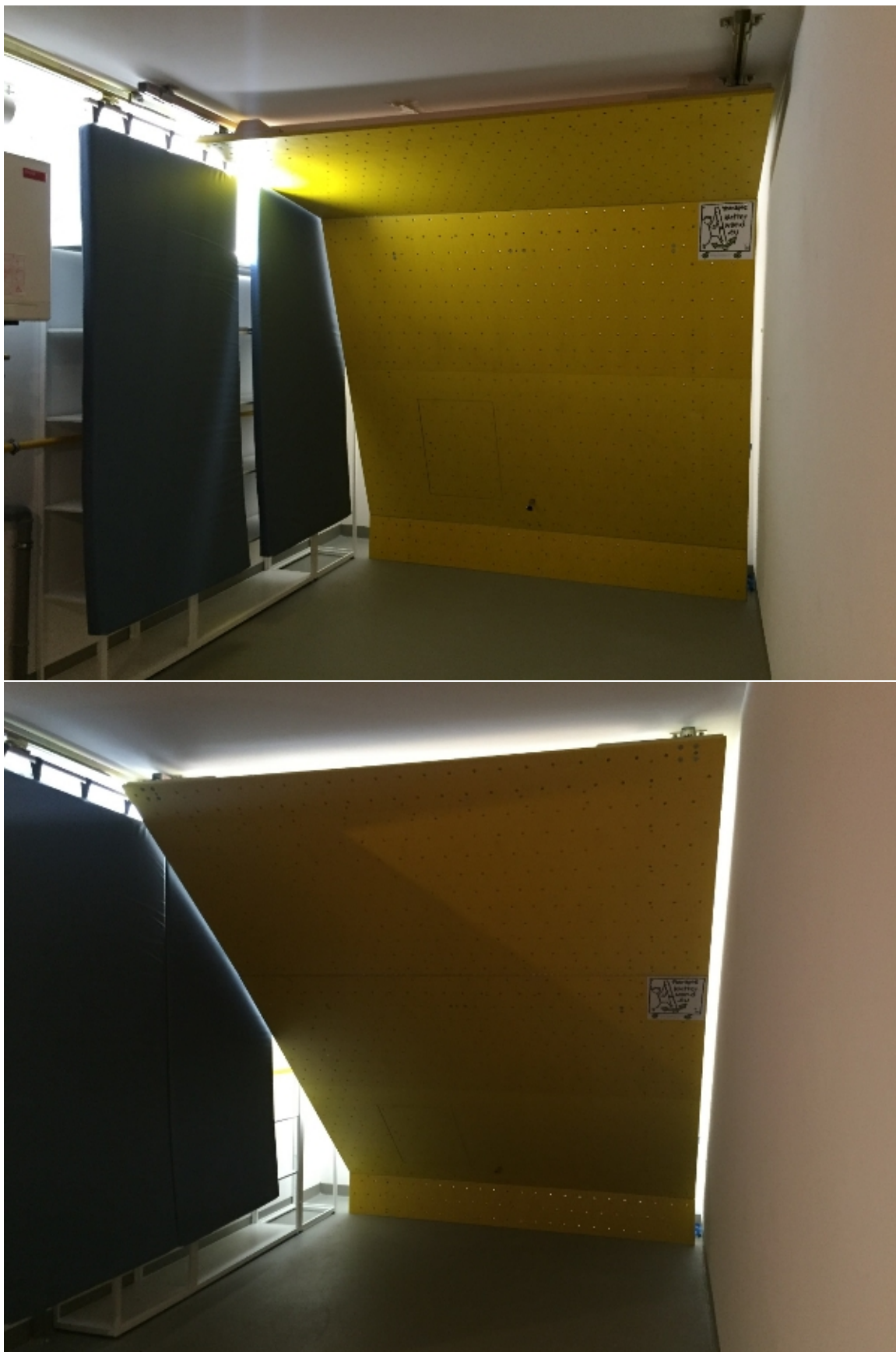
Abbildung 50, Trainingsraum privat Wien mit nur 2,5m Höhe, Kippwand mit Deckenpaneel ergibt voll ausgeschwenkt 3,58m Kletterlänge, verschiebbarer Mattenvorhang vor Regal, versperrbare Klappe für Zugang zu Stauraum hinter der Wand.
