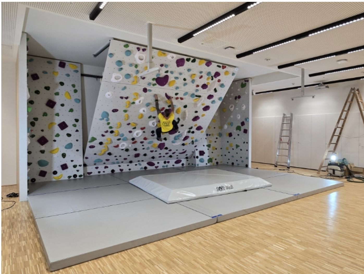
Abbildung 130: 4,5m breite Kippwand mit mitlaufendem Deckenpaneel und fixen geneigten Seitenteilen, UNI Krems
