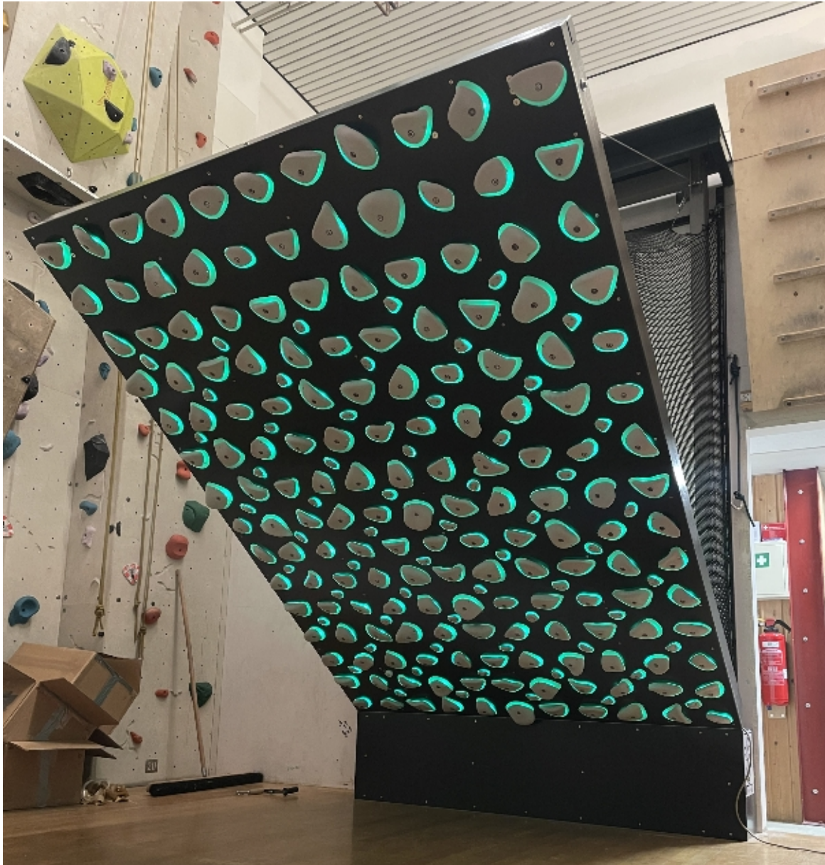
Abbildung 138: B7xH10 Kilterboard DAV Schwabach, mit integr. Handseilwinde und tragender UK
