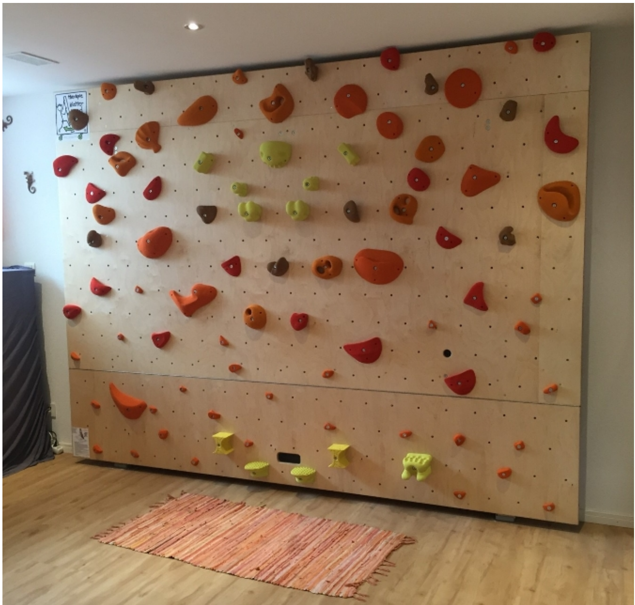
Abbildung 46, 3,2m breite Kippwand in Balkenschuhen mit positiv neigbarem Fußteil - Ersigen Schweiz
