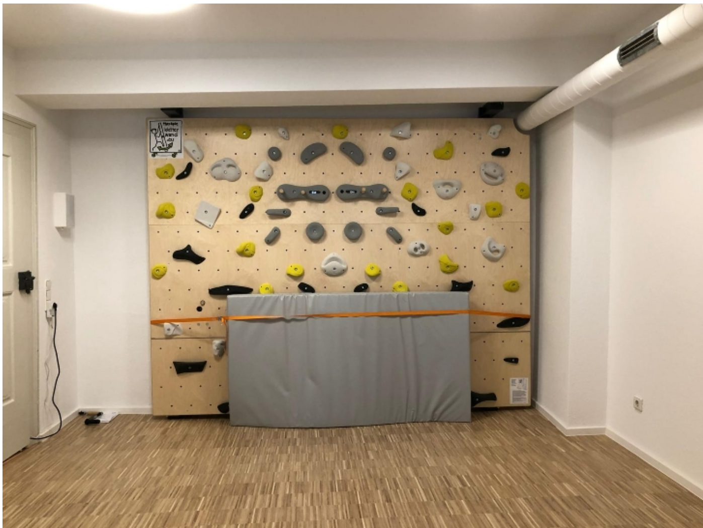
Abbildung 92: Kippwand mit pos. neigbarem Fußteil in altem Fachwerkhaus mit Konsolen vom tragenden Deckenbalken, DE 88287 Grünkraut
