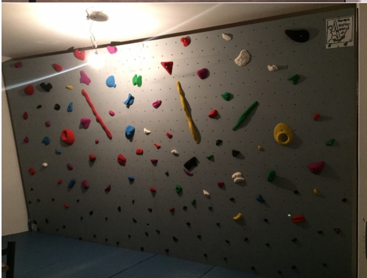
Abbildung 32, 5,5m breite, 3,3m hohe Kippboulderwand mit Balkenschuhen für Systemtraining, privat Forchtenstein - Bgld
