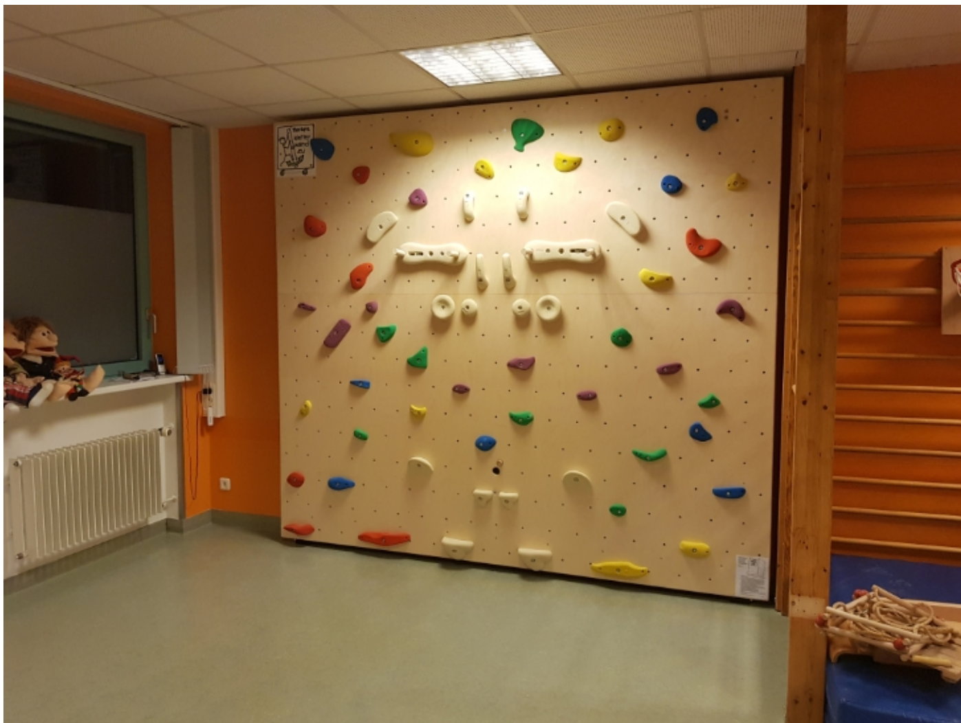
Abbildung 58: Kippwand vor Trockenbau mit Stahlkonsolen durch die abgehängte Decke, DE89331 Burgau
