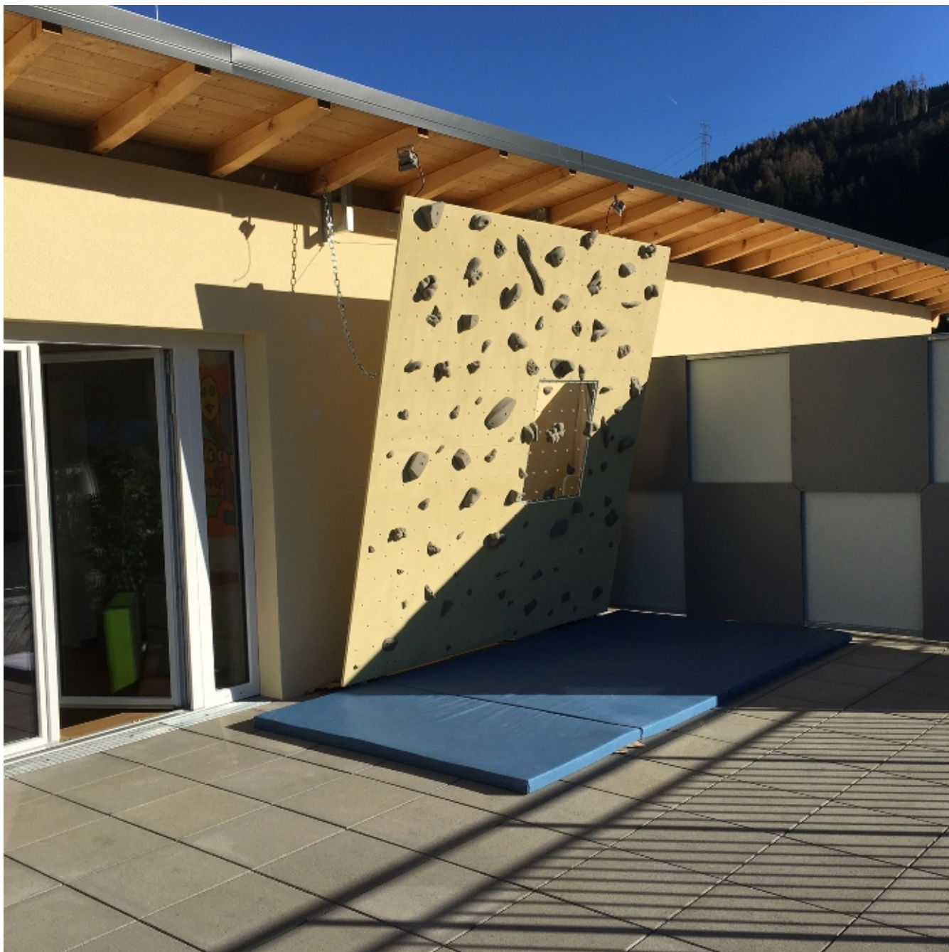
Abbildung 24, sandbeschichtete, voll versiegelte Outdoor Kippwand in Fassadenfarbe mit integrierter Handseilwinde, mit Lichtdurchlass für Badezimmer, mit Schwerkraft unterstütztem Schwenklager, aufgestellt auf lose verlegten Terrassenplatten, privat Tirol
