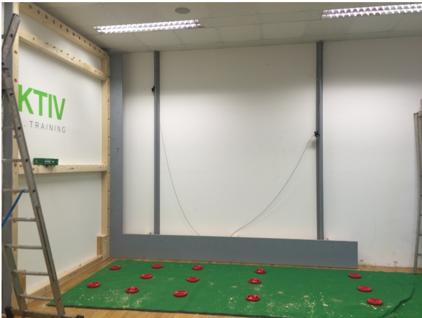
Abbildung 44, Kippwand und fixe Wand ums Eck mit selbsttragender Konstruktion (Trockenbauwände) - Gesundheitsbereich BMW Steyr – OÖ
