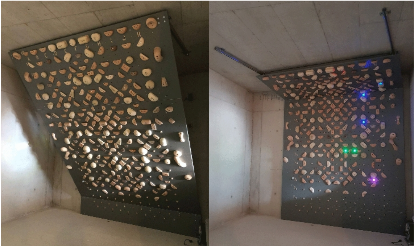
Abbildung 15: ausgef. Tensionboard mit mitlaufendem Deckenpaneel in Kellerraum mit nicht ausreichender Höhe, so Aufwärmen im Senkrechten möglich, privat Tirol
