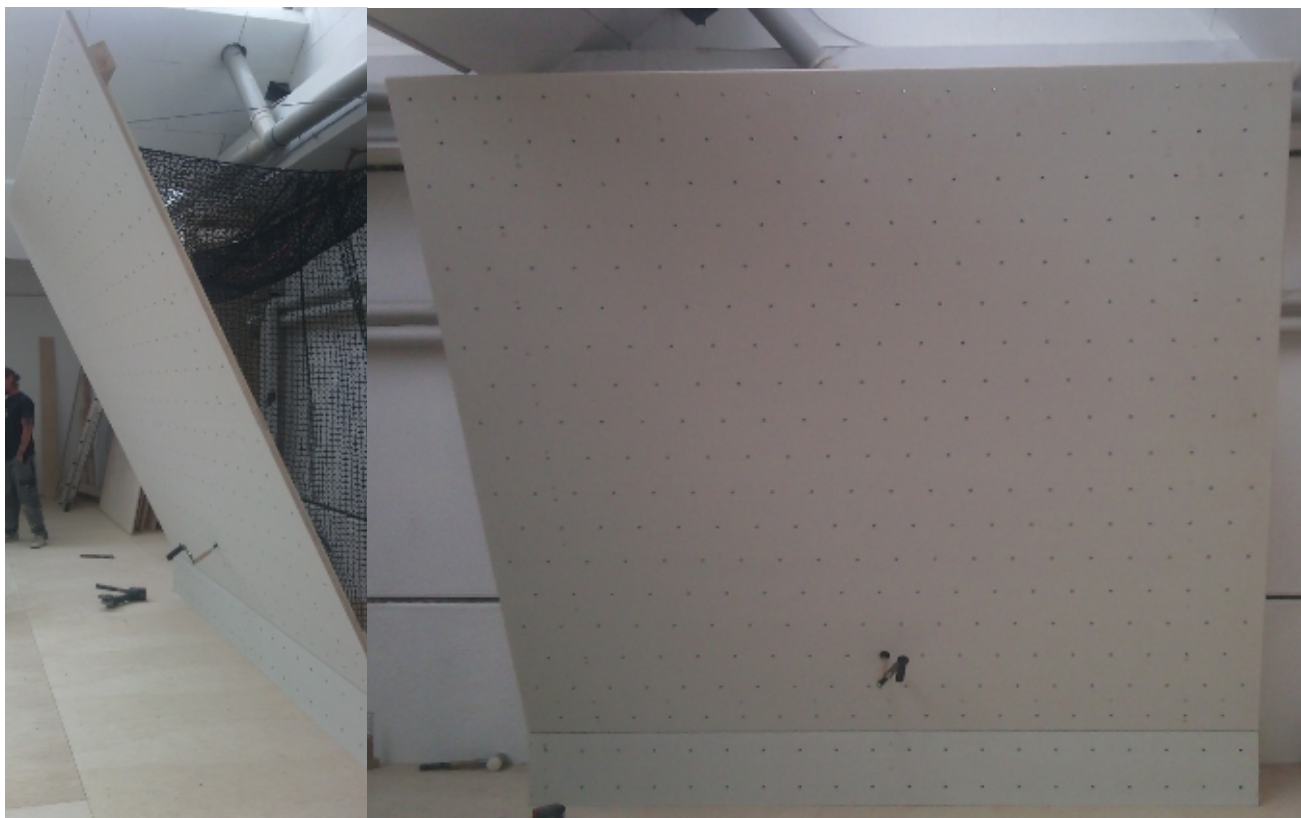
Abbildung 47, beschichtete Systemtrainingswand mit Betretungsschutznetz gebaut für ArtRock – Boulderhalle Steinzeit Göppingen DE
