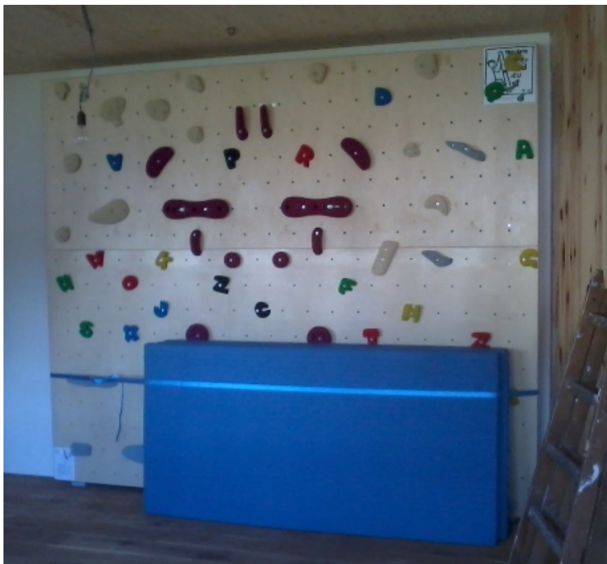
Abbildung 29, Physio Mandler Faak/See, B3xH2,6m, integrierte Handseilwinde, mit Balkenschuhen am Boden stehende Wand, www.physio-faakamsee.at , Kntn
