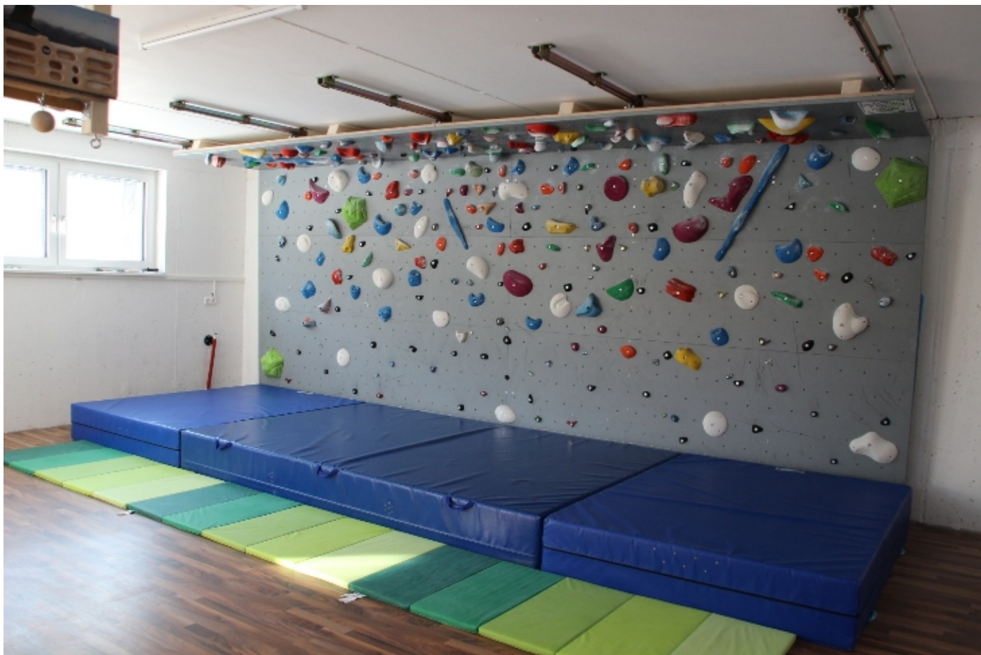
Abbildung 35, 6m breite Kippwand mit mitlaufendem Deckenpaneel, auf 45° ergeben sich 3,5m Kletterlänge bei nur 2,6m Raumhöhe, senkrechte Stellung, privat Rabenstein NÖ
