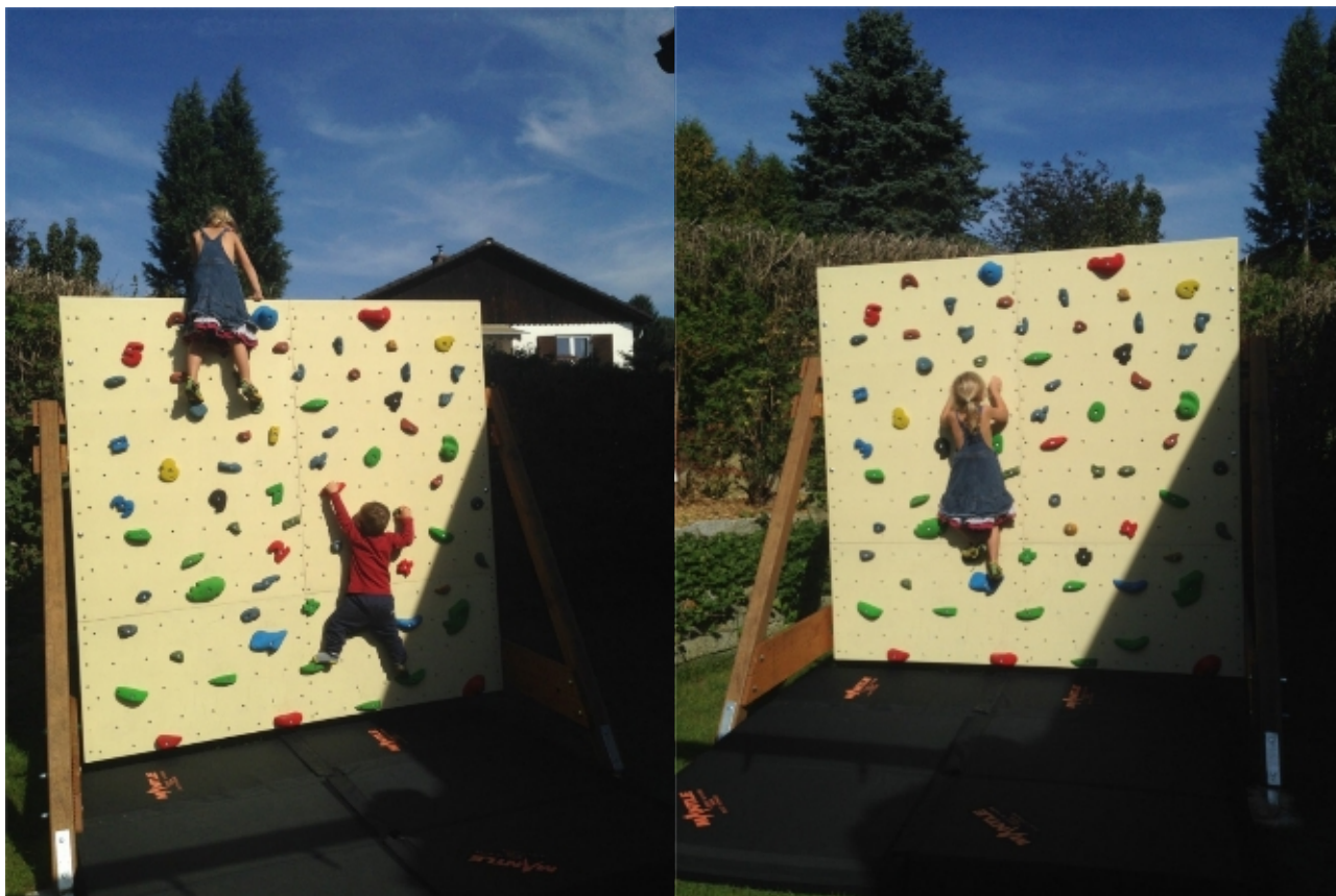
Abbildung 37, freistehende Konstruktion Outdoor, Neigung verstellbar, privat Oberösterreich
