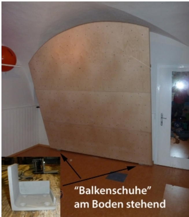
Abbildung 9: Basisausführung - die senkrechten Balken stehen in „Balkenschuhen“
