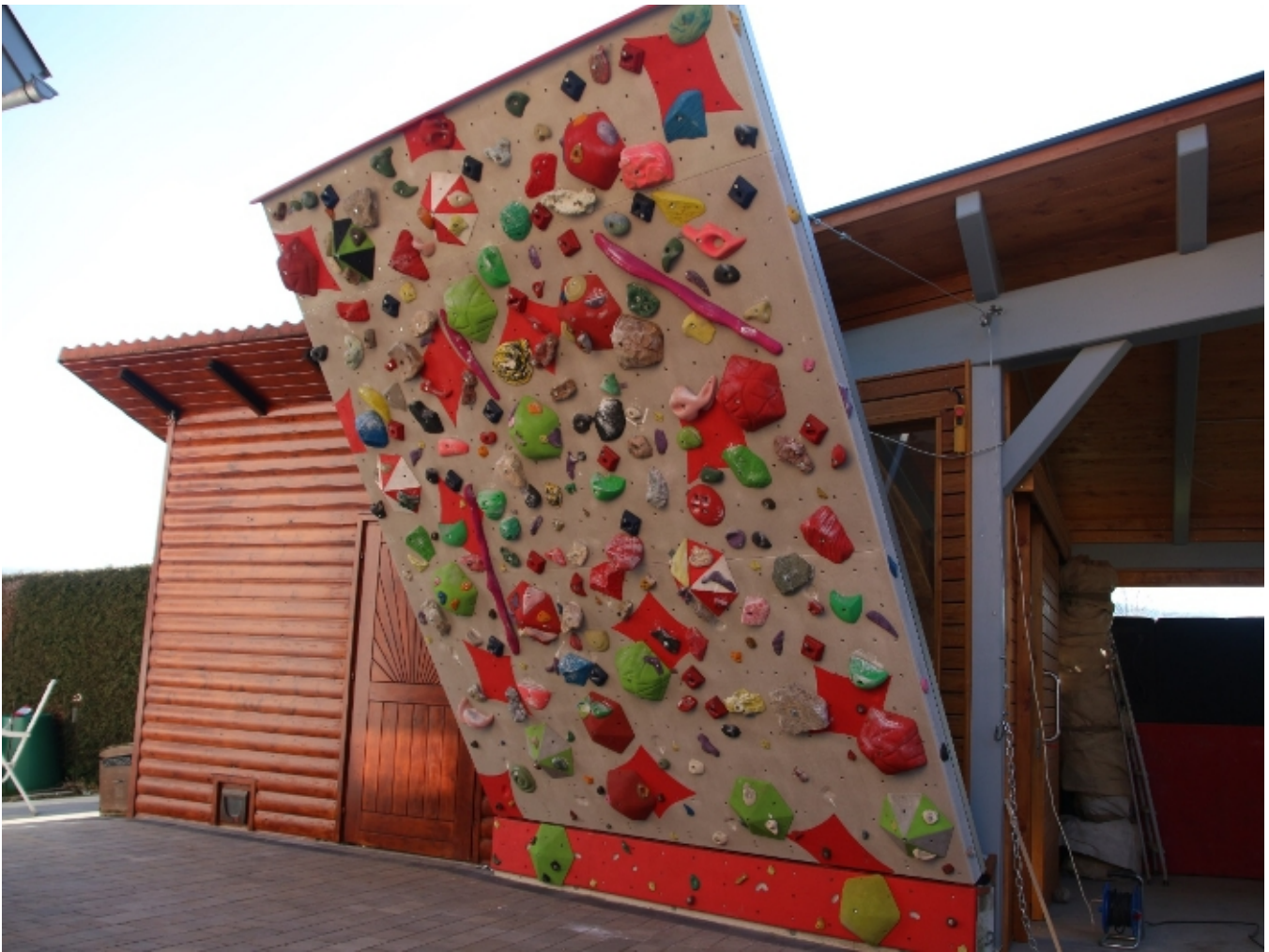
Abbildung 25, Outdoorwand mit Folienverkleidung der Rückwand um Klettern auch bei Regen zu ermöglichen. Dieses Beispiel steht frei ohne Überdachung und ist mit einer elektrischen Seilwinde ausgeführt, privat NÖ.
