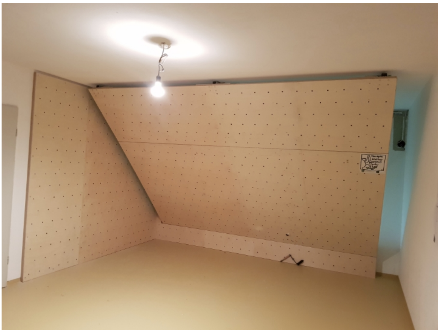
Abbildung 85: Kippwand mit Deckenpaneel und anschließendem Fixteil, Krems NÖ, Eigenbau Dez. 2020
