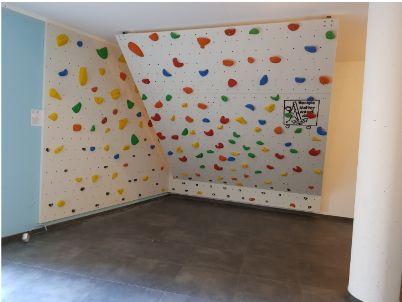
Abbildung 87: Kippwand mit Deckenpaneel und fixer senkrechter Wandteil mit Sand/Epoxi Beschichtung, Enns/OÖ, Sommer 2021
