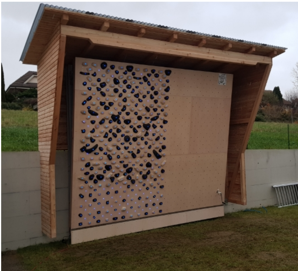
Abbildung 14: ausgef. Beispiel mit Überbreite, integr. Handseilwinde und Lärchenüberdachung, privat CH
