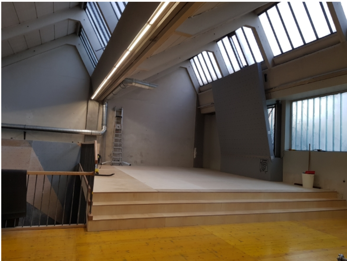
Abbildung 96: elektrisch verstellbares Kilterboard auf Zwischenboden mit fixem Kletterbereich unterhalb. Umbau Blockfabrik/Wien, März 2021
