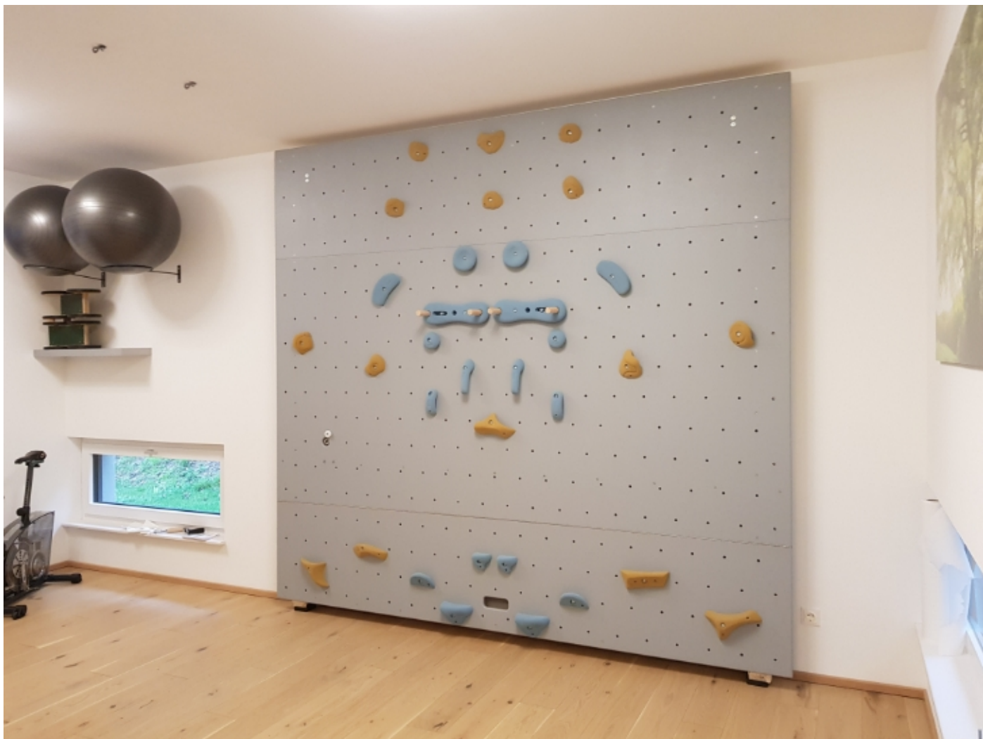
Abbildung 116: Kippwand mit Fußteil, Sand/Epoxi, Physio Thalhammer, Neumarkt am Wallersee, Slzbg
