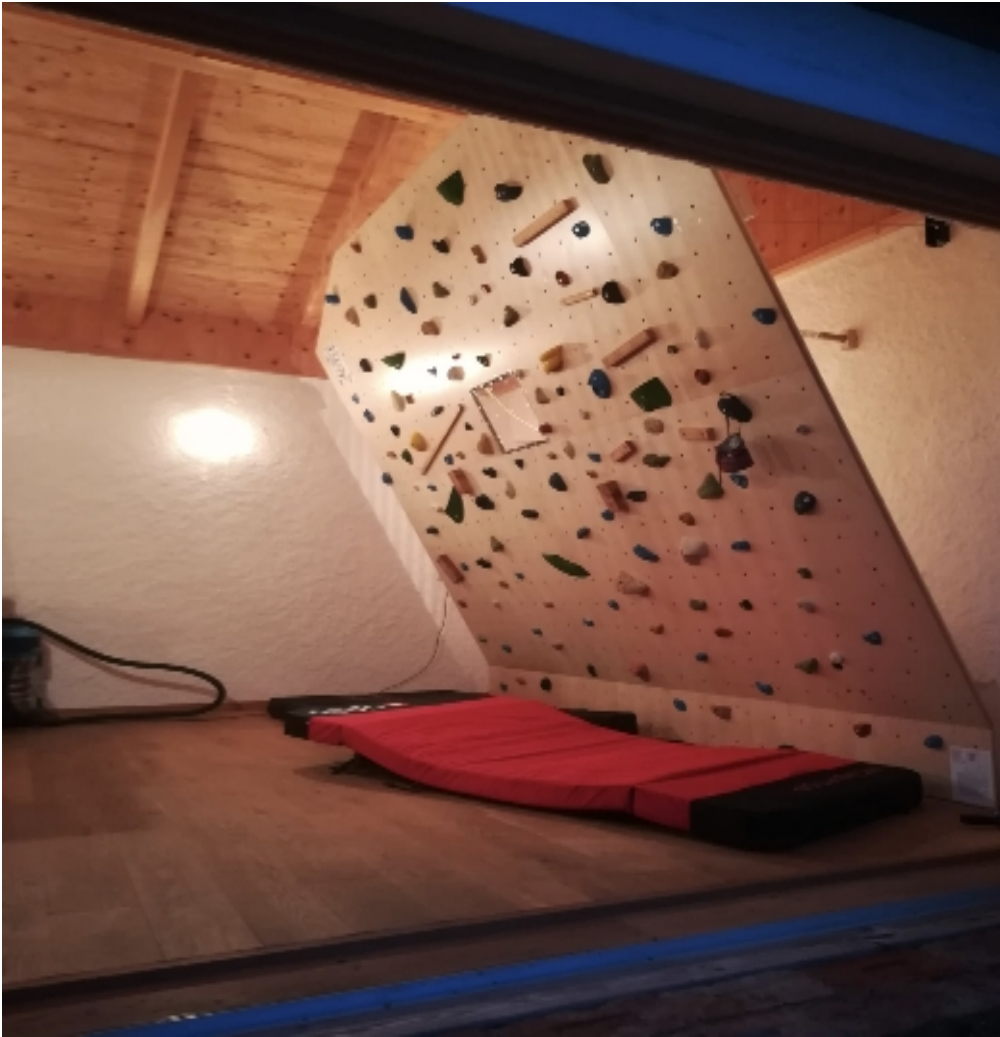
Abbildung 86: Kippboulderwand mit Lichtdurchlass, Purgstall NÖ, privat, Eigenbau Nov. 2020
